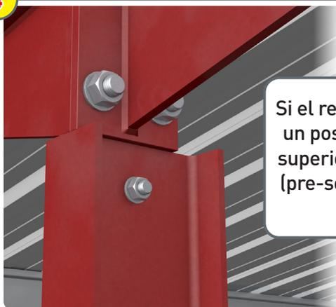
Si el revestimiento del frontón tiene un poste central, atornille la parte superior de este poste a su soporte (pre-soldado) utilizando **pernos 12 x 30**.
