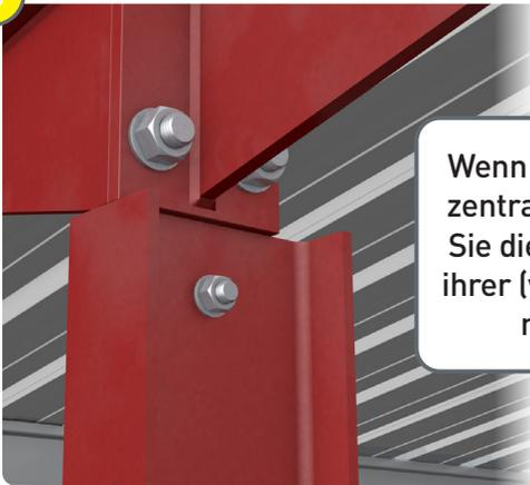
Wenn Ihre Giebelverkleidung eine zentrale Stütze hat, verschrauben Sie die Oberseite dieser Stütze an ihrer (vorgeschweißten) Halterung mit den **12 x 30 Bolzen**.
