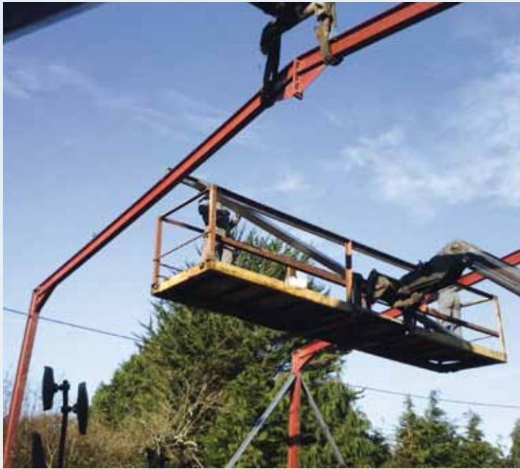
Au départ, le faitage est boulonné au sol, à la main ou à l'aide d'une visseuse. Les pièces sont déplacées avec la fourche du télescopique.
