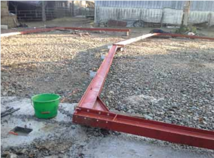
Au départ, le faitage est boulonné au sol, à la main ou à l'aide d'une visseuse. Les pièces sont déplacées avec la fourche du télescopique.
