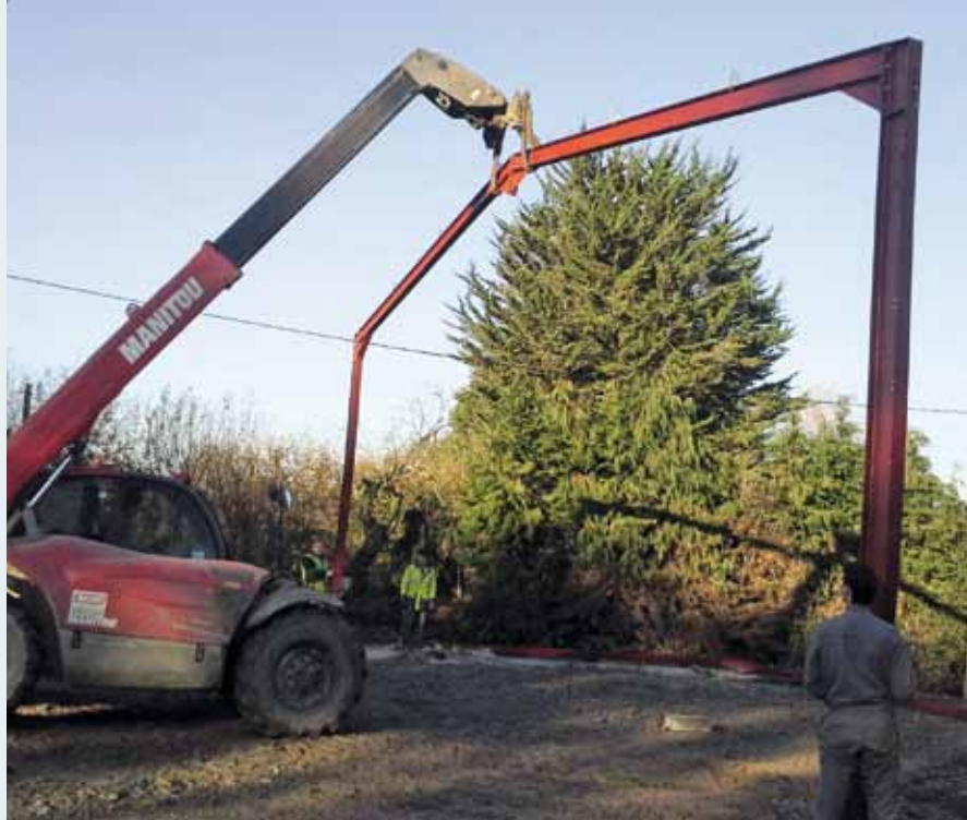
Les fermes sont positionnées à la verticale à l'aide d'un télescopique. Des cales sont placées provisoirement pour permettre le réglage.
